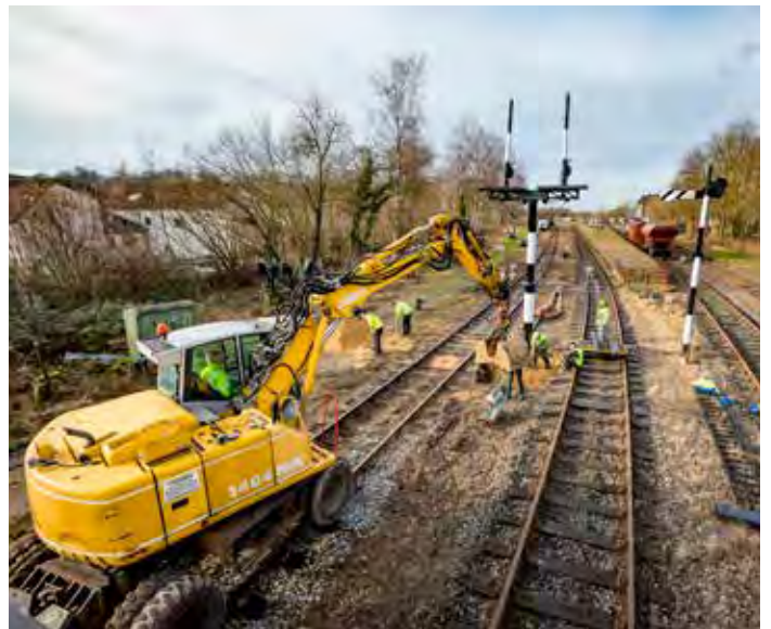
Het bordessein staat op zijn plaats. Het aanbrengen van de details en het sein in werking stellen zijn de volgende stappen. Foto Jasper Kroese
