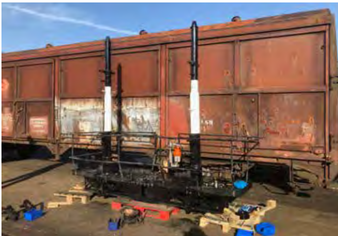
Op 7 november jl. werd het bovenste gedeelte van het sein - het bordes met balustrade en de beide seinpaaltjes - na aankomst in Simpelveld al eens in elkaar gezet. Het begon nu allemaal wel heel concreet te worden! Foto Peter-Paul van Birgelen
