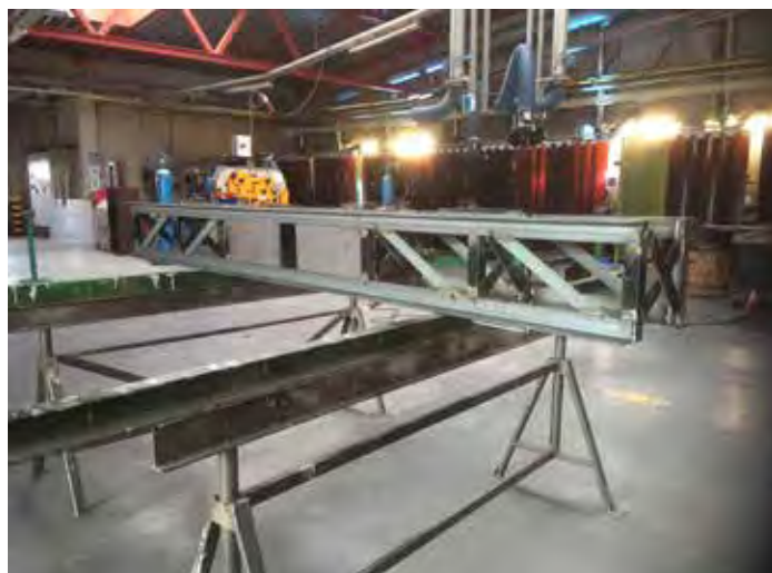
In maart 2020 was de vakwerkstructuur van het bordes al duidelijk herkenbaar. Foto Dave Habraken
