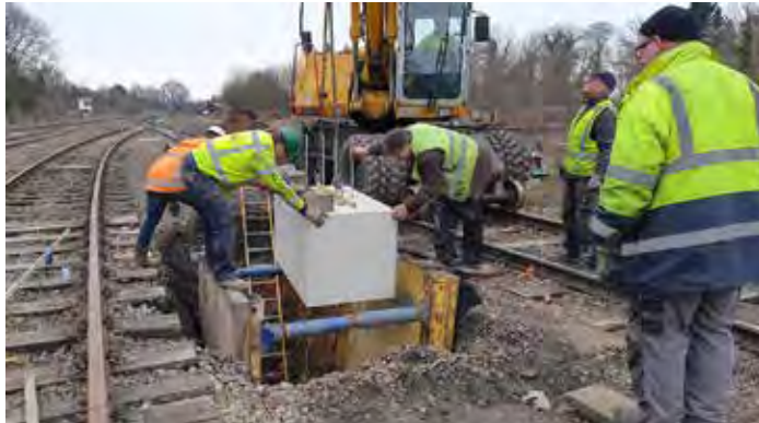
Op 16 januari jl. kon het betonblok als fundament van het bordessein worden geplaatst. Om in het ruim drie meter diepe gat veilig te kunnen werken, werd een sleufkist geplaatst. Deze werd via vrijwilliger Jean-Luc door firma Ploegam B.V. beschikbaar gesteld. Foto Jasper Kroese
