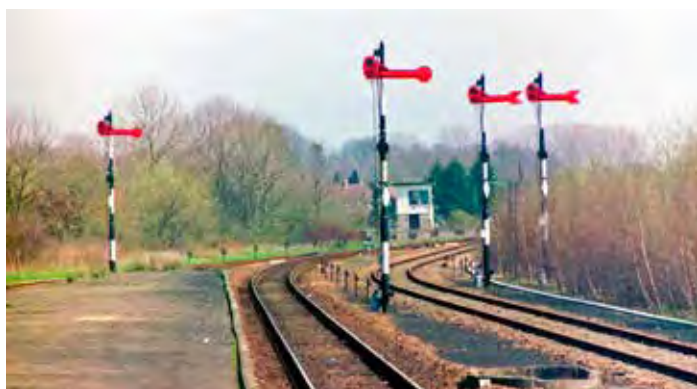
In 1982 werd als vervanging van het bordessein langs spoor 4 een vertakkingsein geplaatst dat bestond uit 2 losse seinpalen die door een bordes met elkaar verbonden waren. Foto P. Meijer
