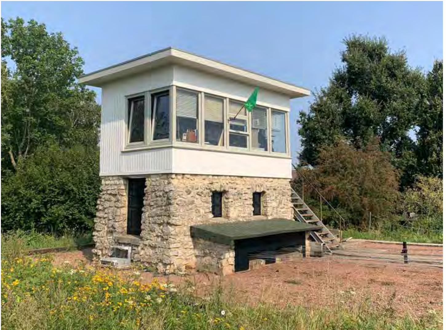
De (sein)vlag kan uit na het afronden van de werkzaamheden aan Post I. Beide seinhuizen staan opnieuw strak in de verf en kunnen er weer een aantal jaren tegen.
