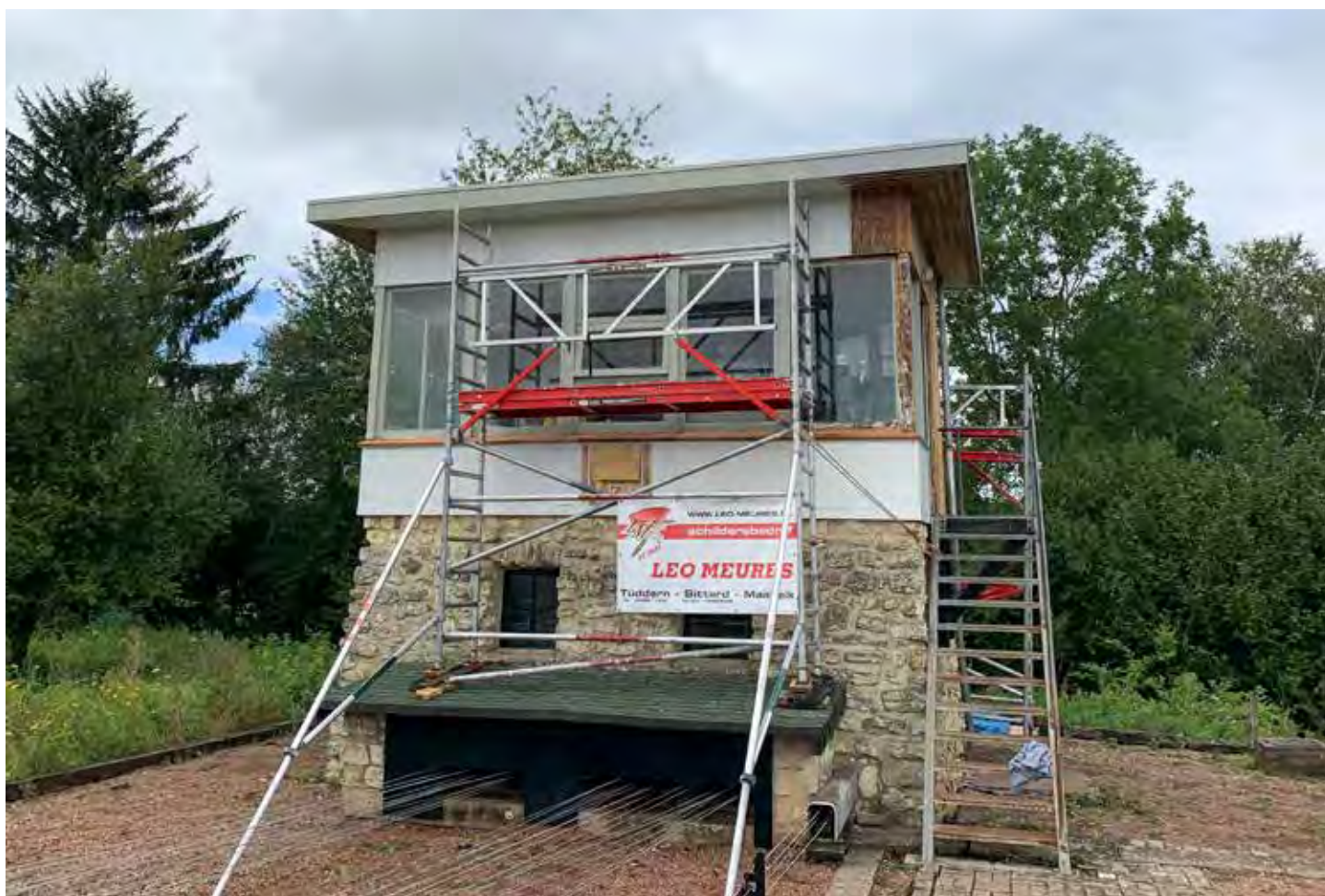
Bij Post I is gestart met het verwijderen van de oude verlaag. Onder het raam is provisorisch een plank aangebracht om het gat af te dichten dat ontstond na het verwijderen van de gevelkachel.
