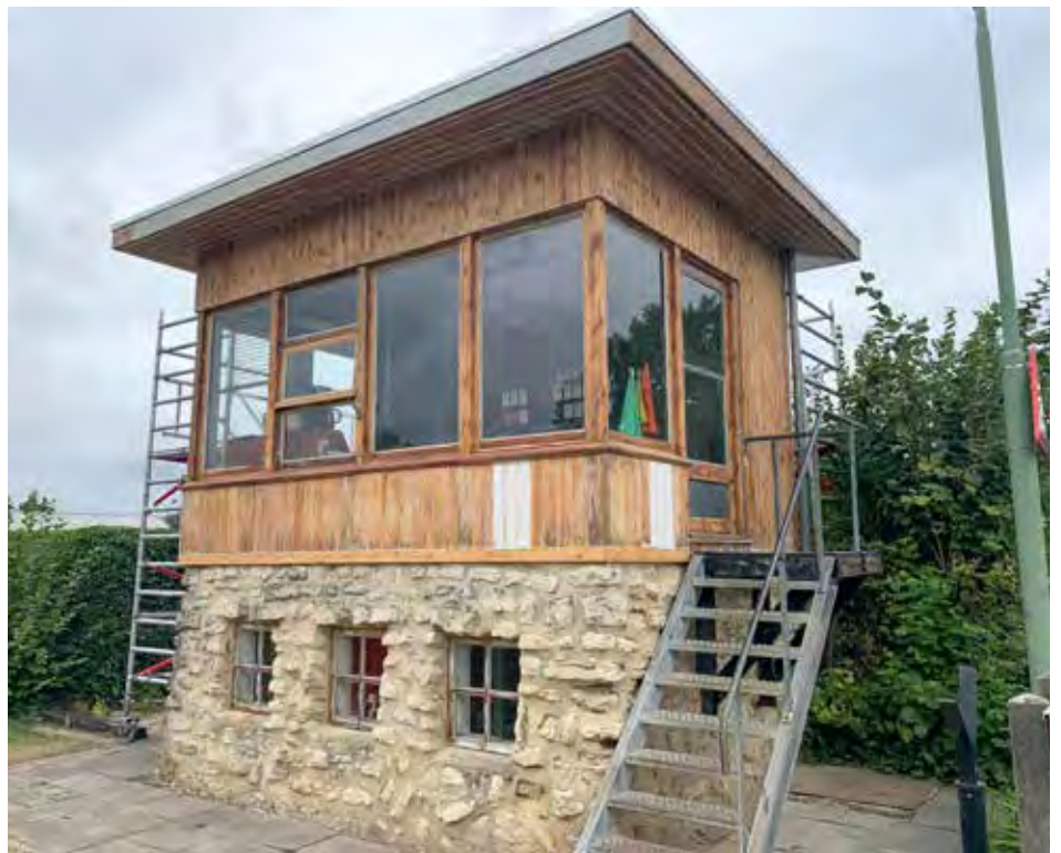
Post II nadat een groot deel van het oude verfwerk is verwijderd. Het liggende gedeelte van het kozijn aan de voorkant is al vervangen door nieuw hout en op de plek waar vroeger de pijp van de gevelkachel zat en aan de zijkant van de post zijn inmiddels nieuwe kraaldelen aangebracht.
